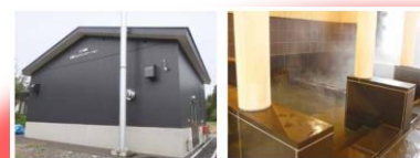
バイオマスボイラー (温泉施設)
