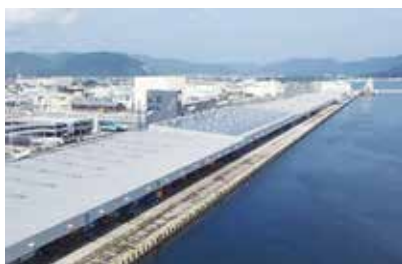
石巻魚市場の屋根に設置された太陽光発電設備
