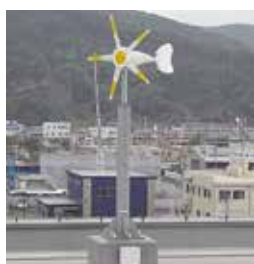
鳥避け用風力発電設備
