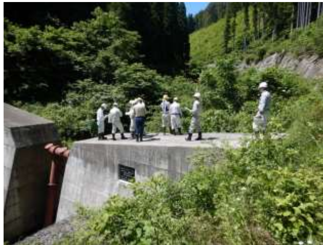
南三陸町貝貫沢（土石流）
