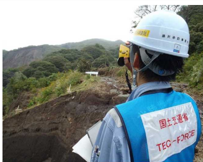
台風26号伊豆大島豪雨災害 緊急調査
