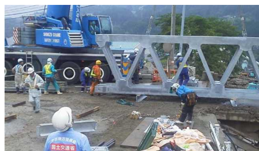
台風8号長野県梨子沢豪雨災害 仮橋架設支援
