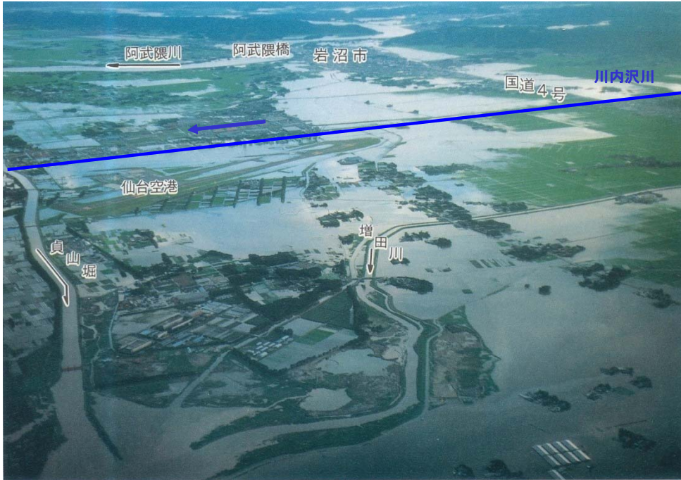
○平成6年9月22日洪水状況（川内沢川下流）
