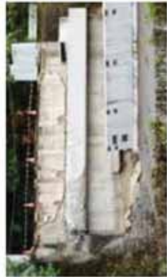
写真-2 横変位拘束構造の破壊、落橋(県道小川嘉島線・府領第一橋)
