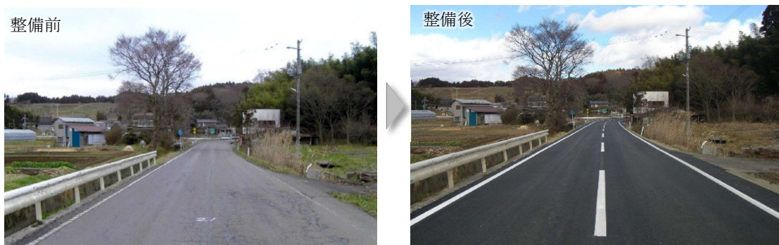
▲ 舗装補修の実施 〔主〕河北桃生線 大田（石巻市）
