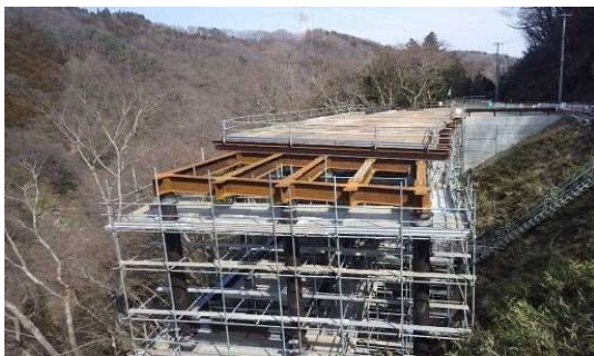
▲ 鋼製栈道橋の整備 〔(国)113号 福岡蔵本（白石市）〕
