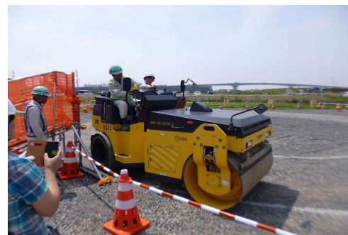
▲ (都)南光湊線 鎮守大橋見学会
