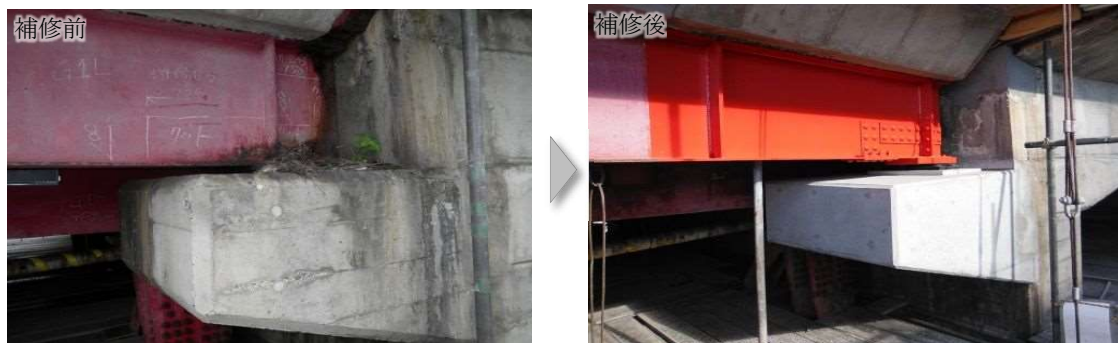
▲ 断面補修等の実施 [(国)286号 釜房大橋 (川崎町)]
