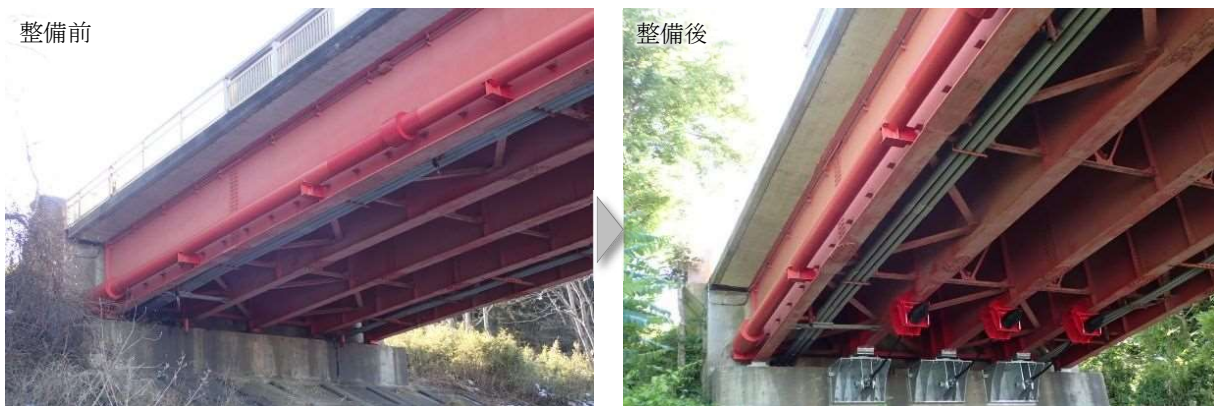
▲ 落橋防止の実施 [(国)346号 感恩橋 (大崎市)]
