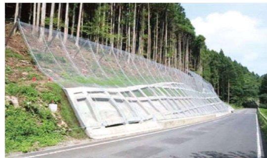
▲ 道路法面对策の実施 〔(一)馬籠東和線 滝沢（気仙沼市）〕
