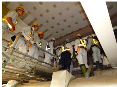
▲桁端部の状況確認
