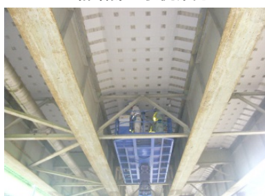
▲主桁の腐食状況確認
