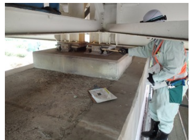
▲沓座の打音検査
