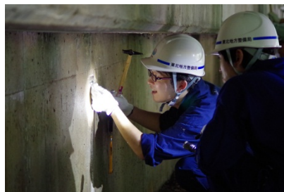
▲下部工のひび割れ幅測定状況
