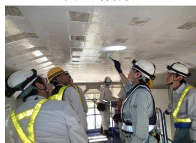
▲床版の打音検査
