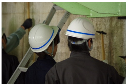
▲下部工の打音による点検状況
