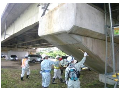
▲橋脚張出し部の打音検査
