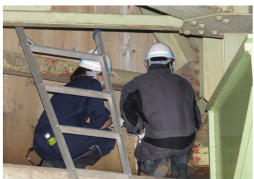
▲桁端部の腐食状況確認
