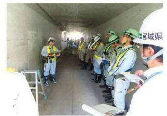
橋梁点検講習会
