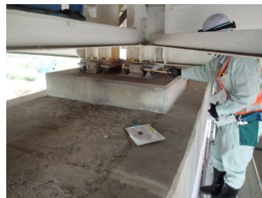
▲沓座の打音検査
