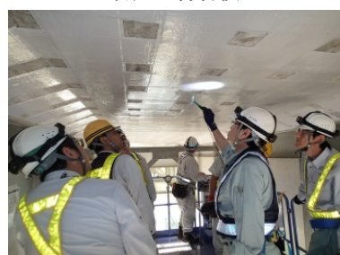
▲床版の打音検査
