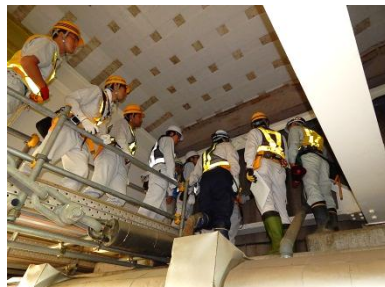
▲桁端部の状況確認
