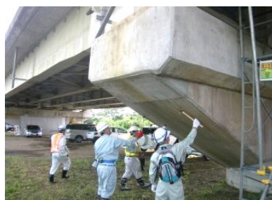
▲橋脚張出し部の打音検査
