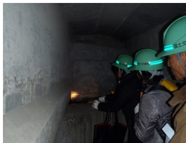
▲多賀城橋の桁下打音体験
