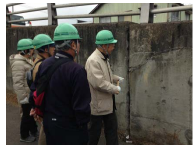
▲一本松大橋の擁壁部打音体験
