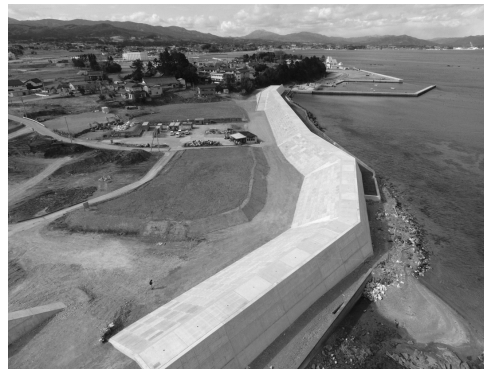
写真－7 復旧した海岸防潮堤 (気仙沼市)
