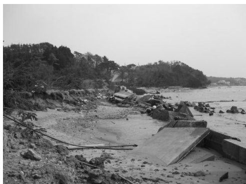
写真-3 海岸防潮堤の被害
