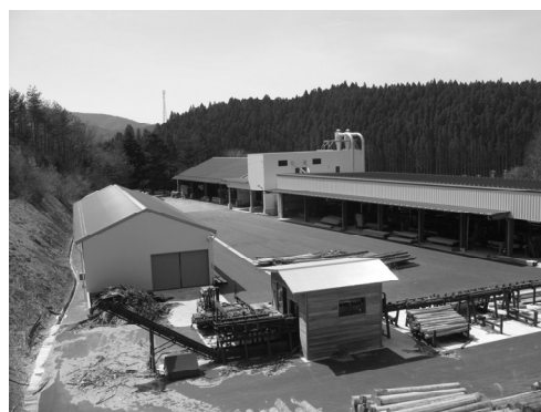
写真－9 復旧した製材工場 (南三陸町)
