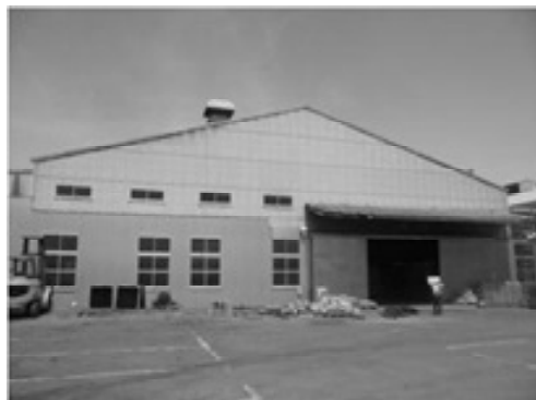
写真－8 復旧した合板工場 (石巻市)
