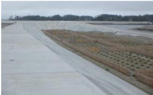
海岸防災林の造成（大曲浜：東松島市）
