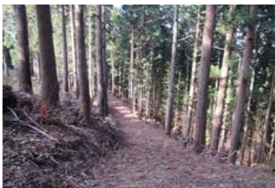
間伐材搬出のための路網整備
