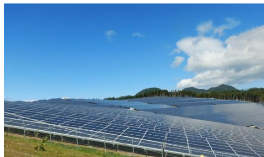
大規模太陽光発電設備設置目的の林地開発
