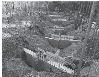
土砂流出を防止する谷止工の施工 (石巻市イガヅキ沢)
