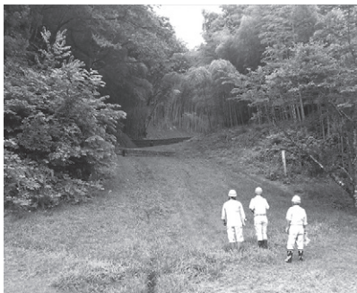
丸森町耕野字入大地区(工事完成)
