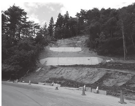
復旧が進む山腹崩壊箇所（明神沢地区） （平成28年10月現在）
