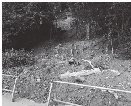
被災時点の山腹崩壊箇所（明神沢地区） （平成27年9月）
