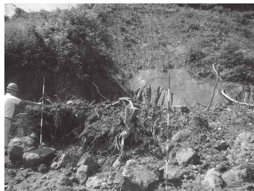
斜面崩壊の様子
