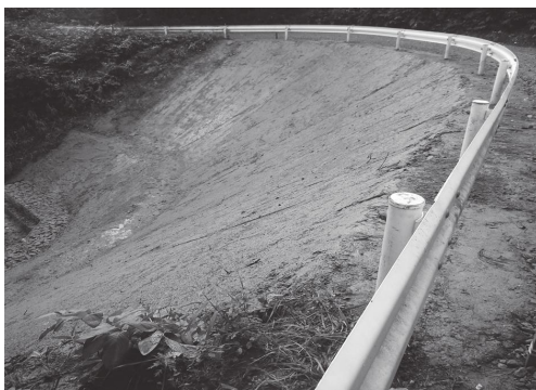
同上復旧状況
