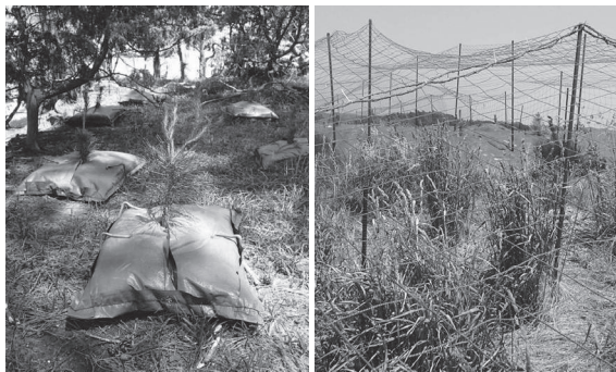
写真右：海鳥除けネットの設置 写真左：植栽パックによる客土施工
