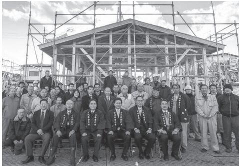
③地域材・地域雇用による災害公営住宅の建設体制の構築 (登米市木造災害公営住宅建設推進協議会)
