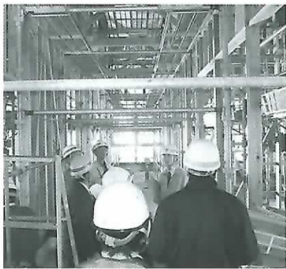
相川保育所建設工事の視察
