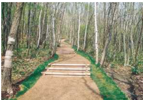
木製階段・チップ舗装
