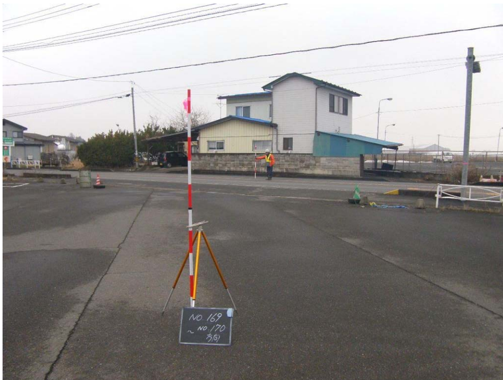
2号橋（高架橋）架橋予定位置
