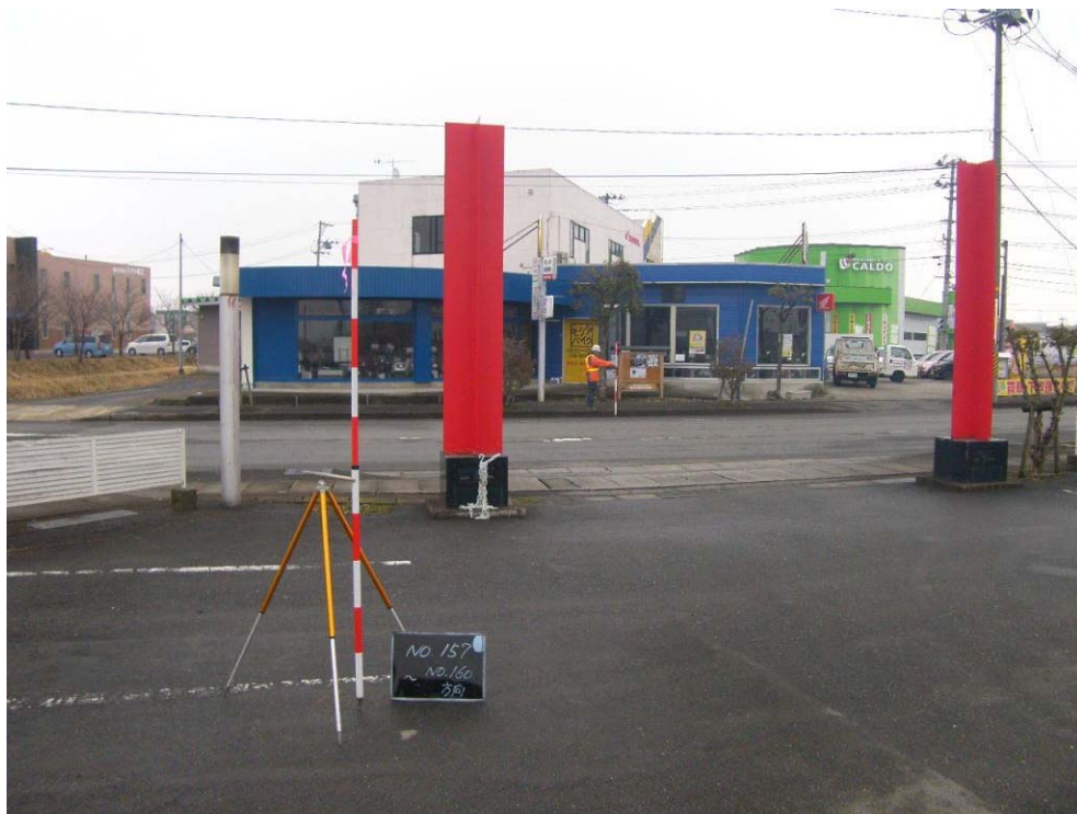
2号橋（高架橋）架橋予定位置
