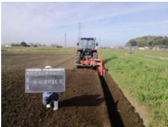
排水溝の設置。深さ 35 ~ 45cm。
