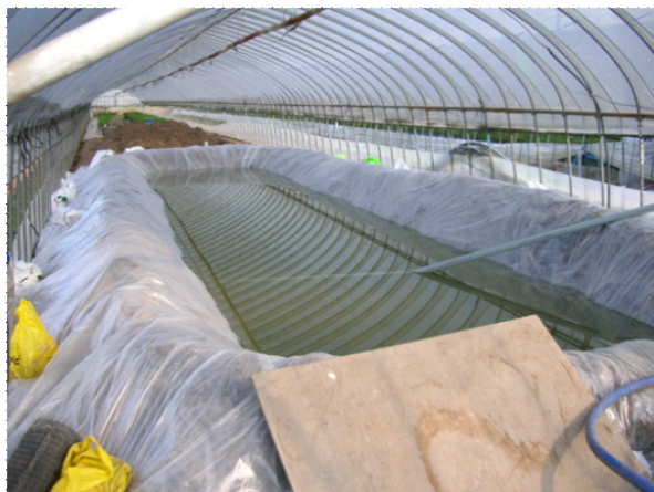
貯水槽の設置
