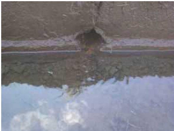
自然落水（弾丸暗渠からの排水）
