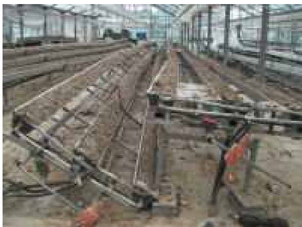
イチゴの栽培施設の被害（美里町） ※転倒した高設ベンチ。（H23.6.24 撮影）
