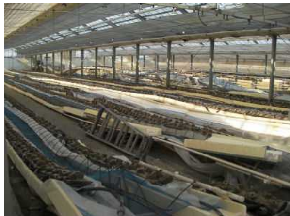
イチゴの栽培施設の被害（登米市） ※転倒した高設ベンチ（H23.6.22 撮影）
