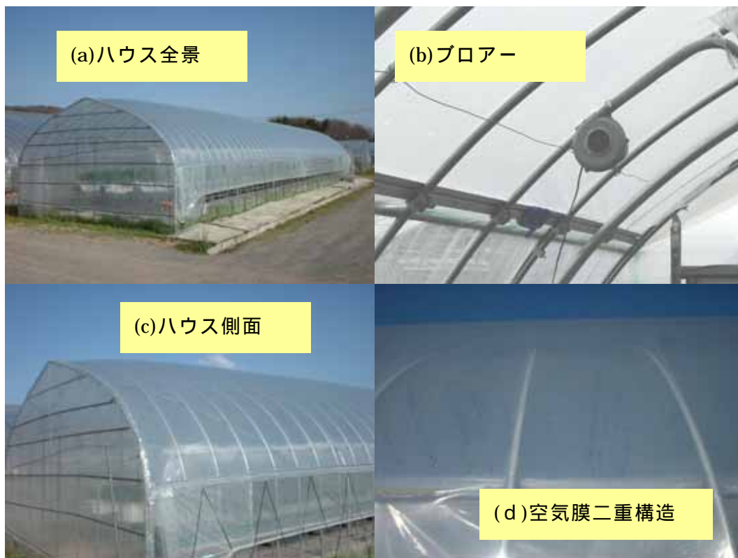
写真 屋根面を空気膜二重構造としたパイプハウス
