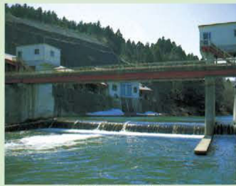
②門沢取水堰・取水口
