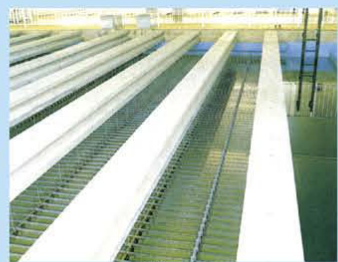
⑦薬品沈澱池
