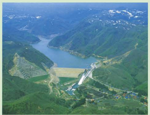
①漆沢ダム
