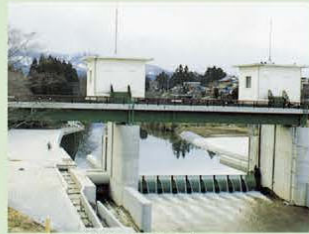
②魚板取水堰・取水口
