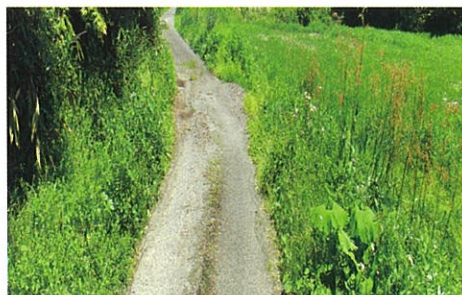
柳田峠2期地区 (着手前) 起点側
