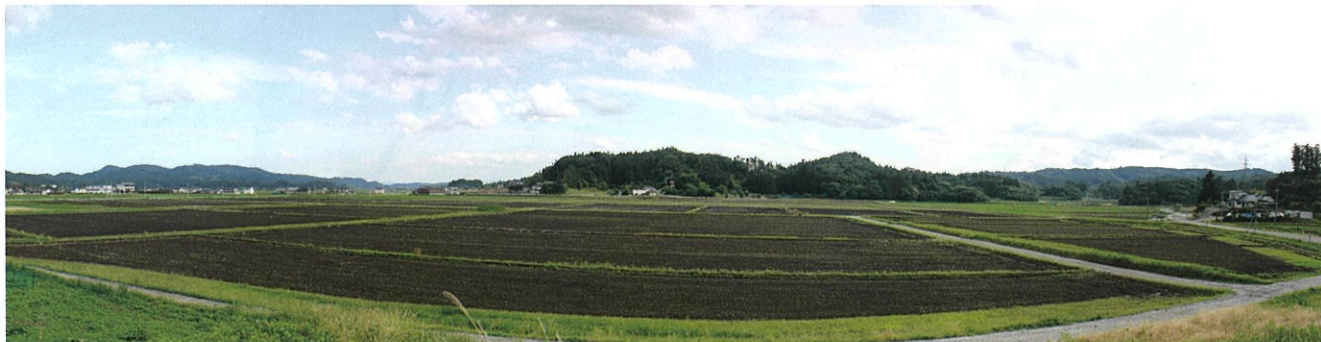
針生前地区 (完成状況)
