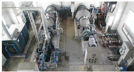
南田排水機場（現況）
