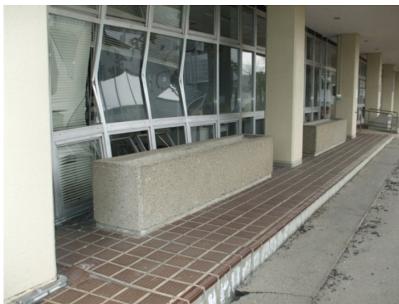
1階事務室外観
