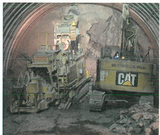
志賀・姥ヶ懐トンネル掘削現場
