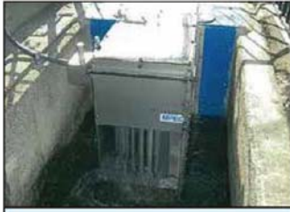
勾配の小さな開水路を有効活用でき、追加の土木工事が不要なタイプ。
