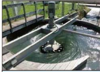
低落差の水路に設置可能で、魚などが通過することができる環境配慮型。
