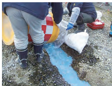
写真 亀裂への石灰水の注入
