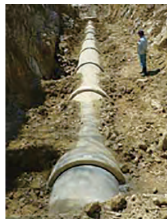
写真 パイプラインの試掘
