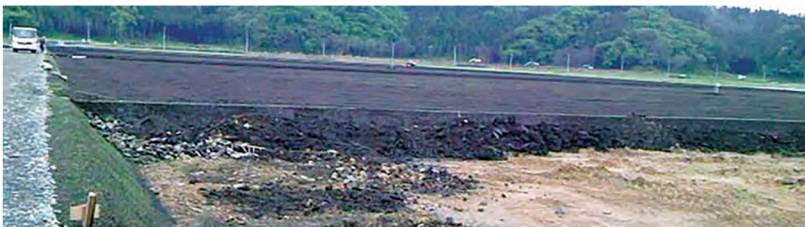
写真2 営農条件に合わせて盛土された農地（手前は盛り土前）
