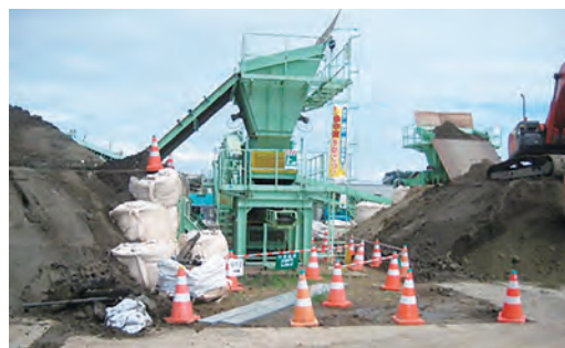
写真3 瓦礫除去プラント
