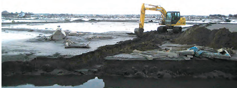
写真 津波の応急排水時における湛水排除のための排水路掘削
