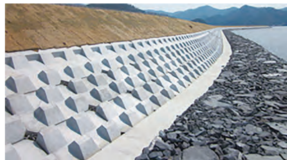
写真2 二次製品による海岸工
