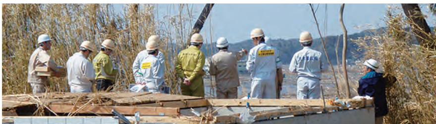
写真 業者と県担当者が現場で打ち合わせ
