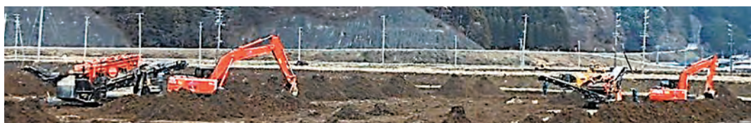
写真1 自走式石礫選別機とバックホウによる瓦礫除去作業
