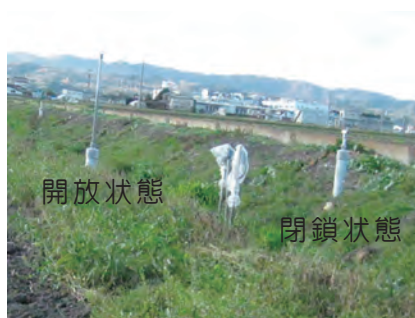
写真2 開放状態の水閘
