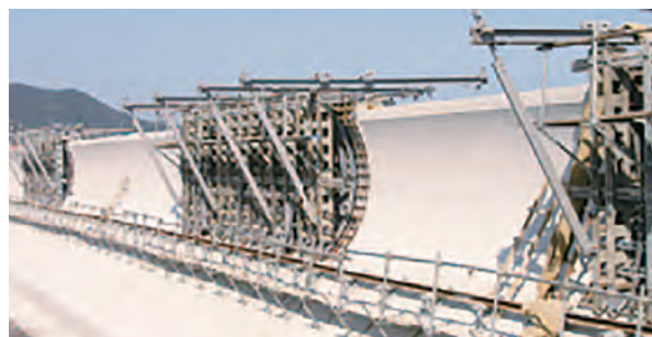
写真2 移動型枠工法
