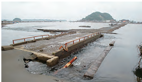
写真1 水没した宮城県・須崎地区の農地
