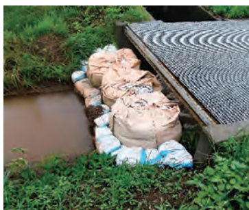
土のうによる用排分離
