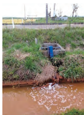
水中ポンプによる排水
