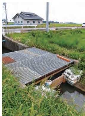
堰板による用排分離
