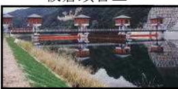
伊豆野頭首工
