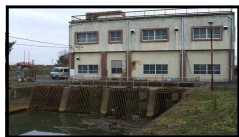
寺野排水機場
