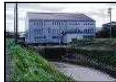
鶴家排水機場 (現況)
