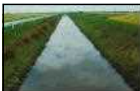
旧古川排水路 (現況)
