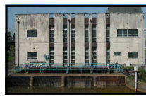
藤曽根排水機場
