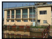
相の釜排水機場
