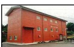
新山揚水機場
