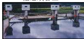
一の堰頭首工
