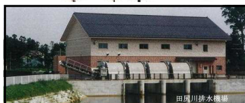
田尻川排水機場
