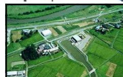
涌谷西排水機場
