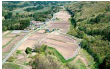
県営中山間地域総合整備事業 セブネ2期地区(大原工区)
