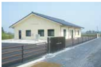
農業集落排水事業 長谷地区(登米市)
