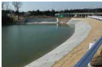
ため池等整備事業 勝負沢地区(大和町)
