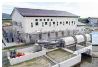
上:国営中津山地区 (石巻市・登米市・鶴家排水機場)
