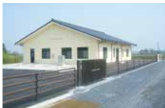
農業集落排水事業 長谷地区(登米市)
