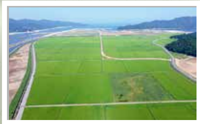
被災農地の復旧状況(大川地区長面工区)
