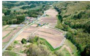
県営中山間地域総合整備事業 セブネ2期地区(大原工区)
