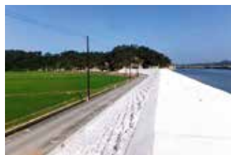
農業用施設災害復旧事業 松ヶ島地区(東松島市)
