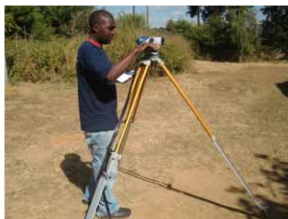
写真2 オートレベルの点検
