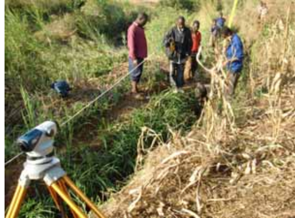
写真3, 4 測量の状況（水路勾配の設定）
