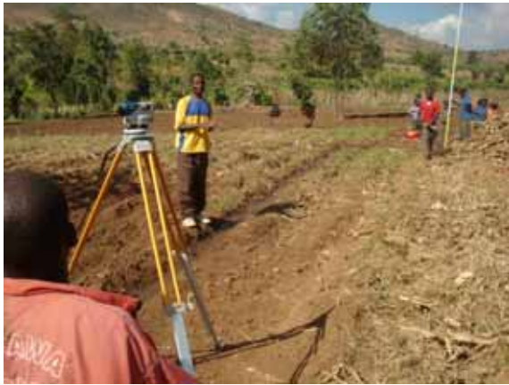
写真3, 4 測量の状況（水路勾配の設定）
