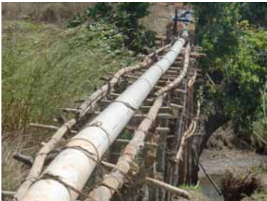
写真7, 8 : 水管橋 カゴ水路 仮設橋台 コンクリート橋台へ移行
