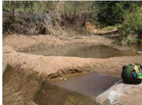
写真 1 1 , 1 2 : 堆砂により機能低下した堰
