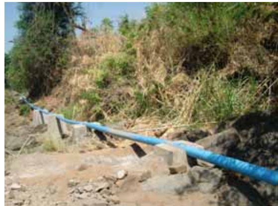
写真5, 6 : 取水堰からの導水はパイプライン化される事例が多い
