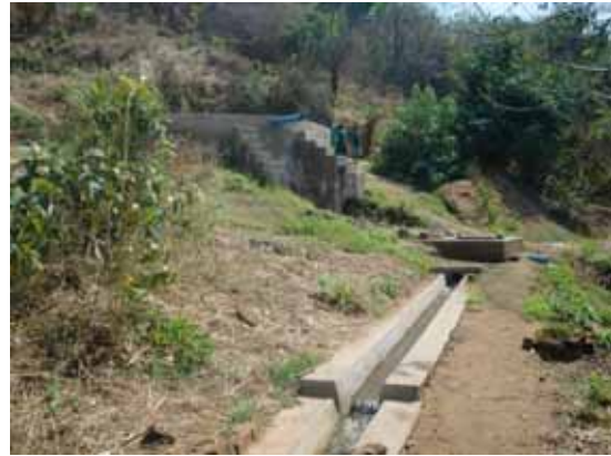
写真 2 2 , 2 3 : 河川から導水した水量を貯留し用水調整をする
