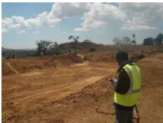
写真16：貯水池の施工
