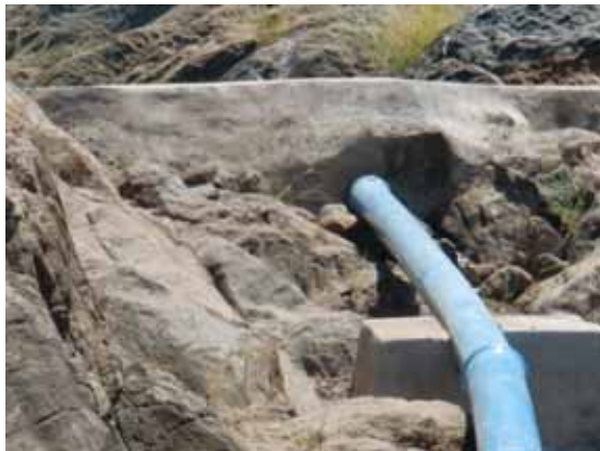
写真5, 6 : 取水堰からの導水はパイプライン化される事例が多い
