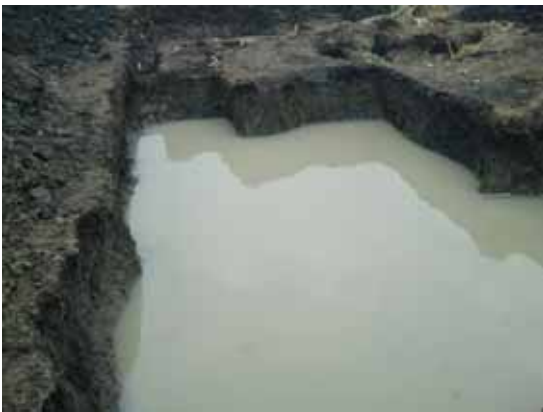
写真 2 4 : 掘り下げて自由面地下水を利用
