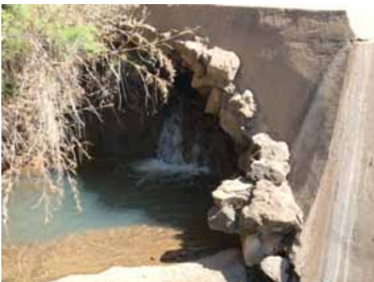
写真 1 3 : 堰の破損
