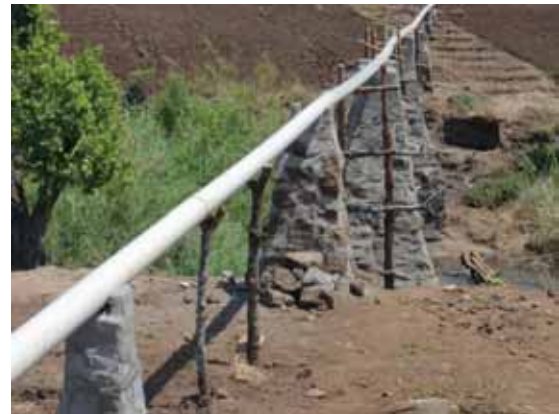
写真7, 8 : 水管橋 カゴ水路 仮設橋台 コンクリート橋台へ移行
