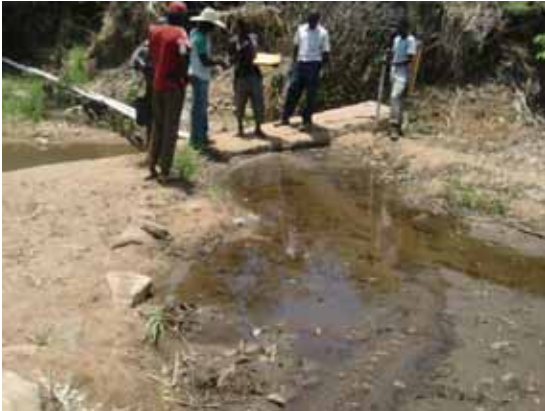
写真 1 1 , 1 2 : 堆砂により機能低下した堰
