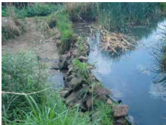
写真1, 2: 従来の自然素材を利用した仮設的な取水堰
