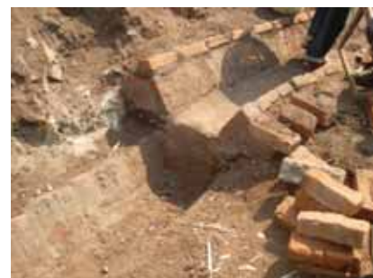
写真2, 3：水路の施工（レンガにセメントで舗装）
