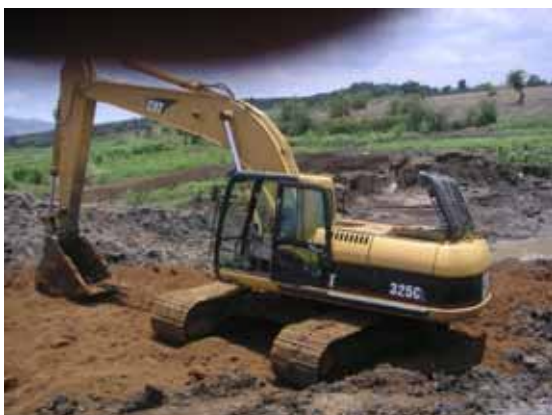
写真5：重機による施工
