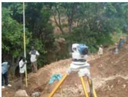
写真4：水路勾配の設定
