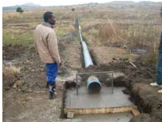
写真6：サイフォンの埋設前の出来形確認
