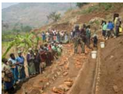
写真2, 3：水路の施工（レンガにセメントで舗装）
