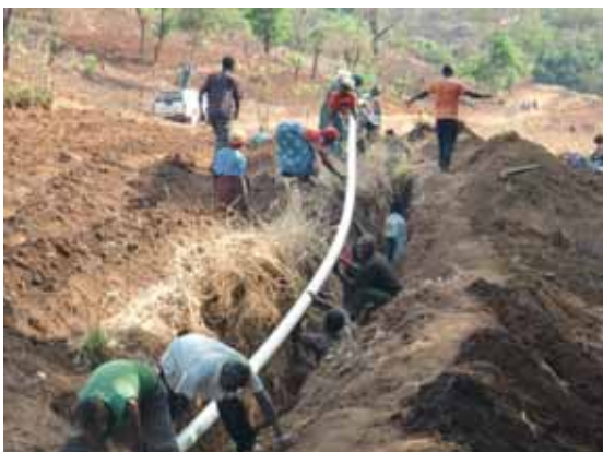
写真7：暗渠の布設
