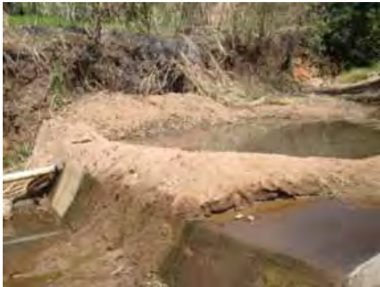
写真3：コンクリート取水堰
