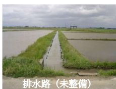
排水路（未整備）
