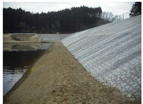
整備された農業用ため池(大崎市鹿島台:貝抜ため池)
