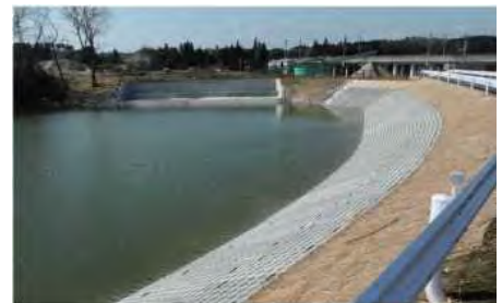
整備されたため池
