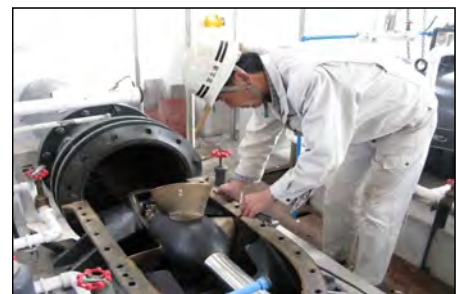
ポンプ設備の機能診断
