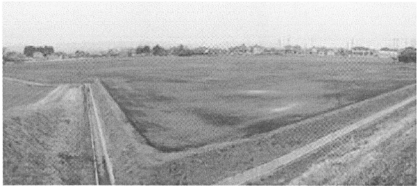
写真5 農地復旧・除塩工事が終了した農地
