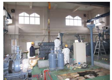
被災した排水機場の応急復旧(東松島市)(H23年3月)
