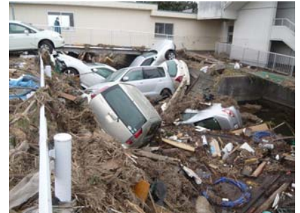
農業用幹線排水路の被災(亘理町)(H23年3月)
