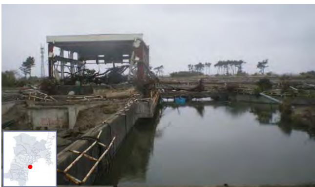
大堀排水機場の被災(仙台市若林区)
