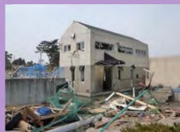
被災状況(平成23年3月)
