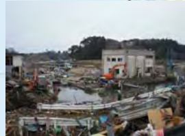
⑦排水機場被災状況 (東松島市：中下排水機場)
