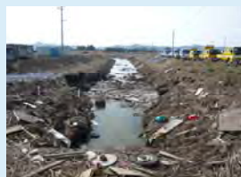
⑬排水路被災状況 (亶理町：枝川排水路)
