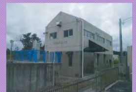
復旧完了(平成25年3月)
