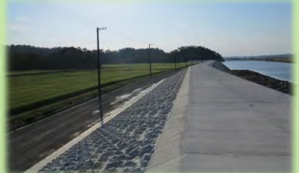
農地海岸堤防「松ヶ島地区」復旧後（平成27年6月）
