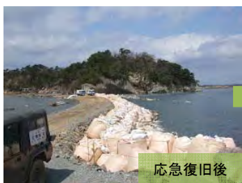
③農地海岸応急復旧(東松島市)
