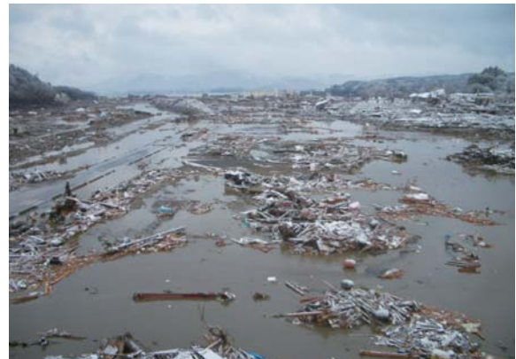
▲写真 庁舎周辺は壊滅的な被害を受けた (庁舎屋上より撮影)
