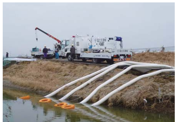
▲写真 大堀排水機場（仙台市）応急排水状況
