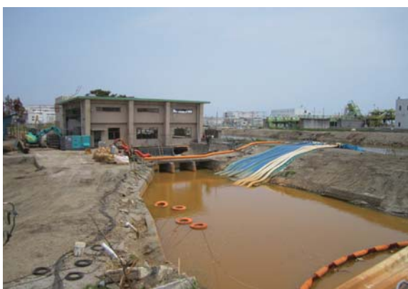
▲写真 高砂南部排水機場（仙台市）応急排水状況
