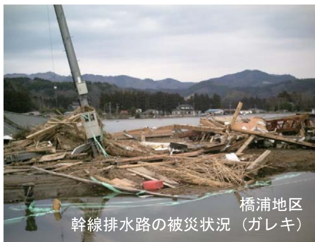
橋浦地区 幹線排水路の被災状況（ガレキ）
