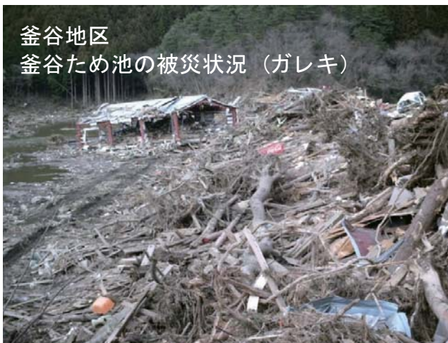
釜谷地区 釜谷ため池の被災状況（ガレキ）
