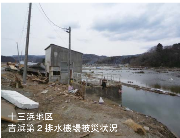
十三浜地区 吉浜第2排水機場被災状況
