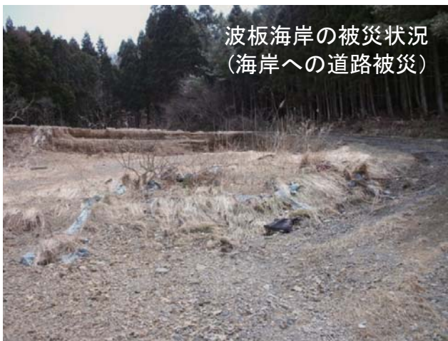
波板海岸の被災状況 (海岸への道路被災)
