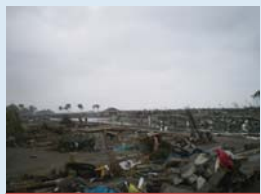
⑪農地被災状況 (仙台市: 大堀排水機場周辺)
