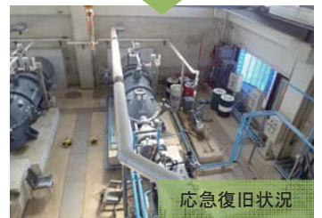
③排水機場応急復旧 (亶理町:荒浜第2排水機場)
