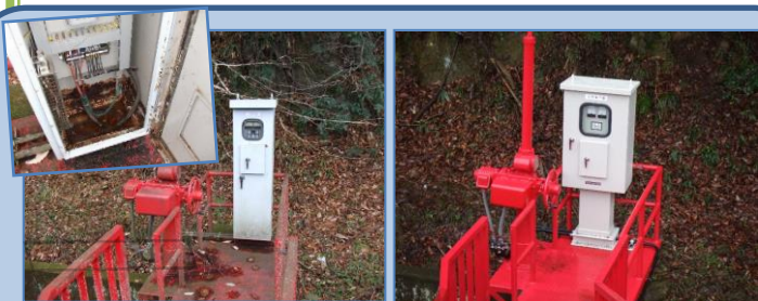
ゲート操作盤更新・巻上機の分解整備及び塗装
