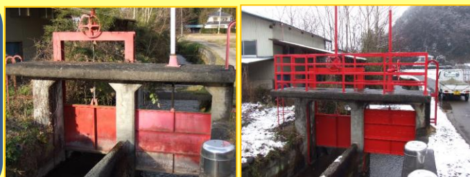
ゲート巻上機更新・扉体、戸当り塗装・操作台手摺り設置
