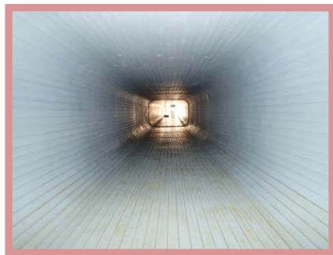
排水樋管補修工事完成
