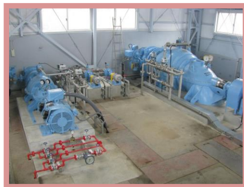
ポンプ補修工事完成
