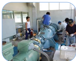
1.小配管取り外し
