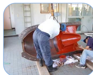
6.上ケーシング内部塗装
