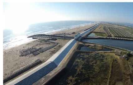
④工事の完了状況(H29.3)
