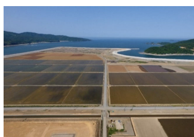
⑦復旧状況（長面工区 R2.6）
