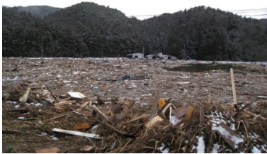
①被災状況（針岡工区 H23.3）
