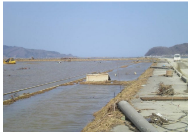
②被災状況（長面工区 H23.4）
