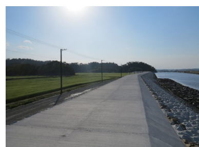
②工事の完了状況(H27.5)
