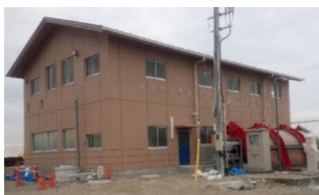
③復旧状況(H27.3)
