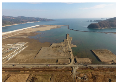
⑤農地海没状況（長面工区 H28.12）
