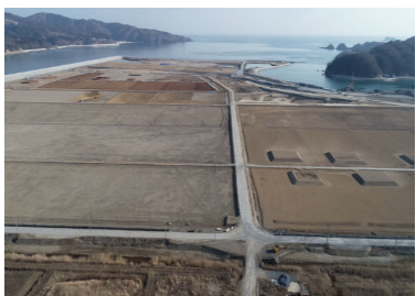
⑦農地の表土盛土（長面工区 H31.1）
