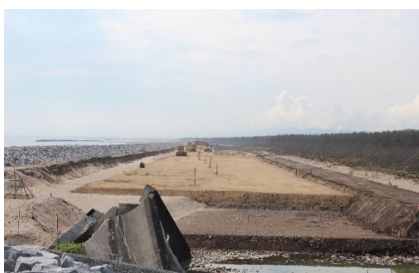
③本復旧の状況(H24.9)
