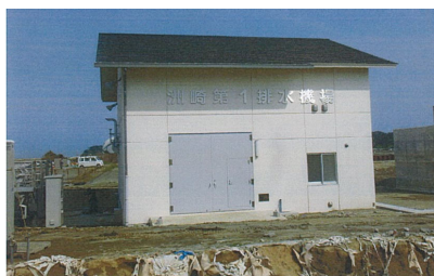
②復旧状況(H25.11)
