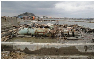
①被災状況(H23.3)
