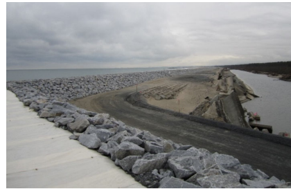
②応急仮堤防設置状況(H23.12)
