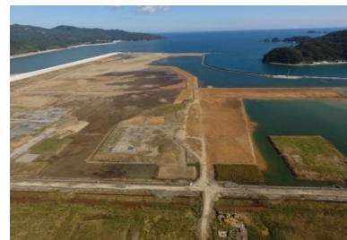
⑥農地を干陸化するため仮堤防設置（長面工区 H29.10）
