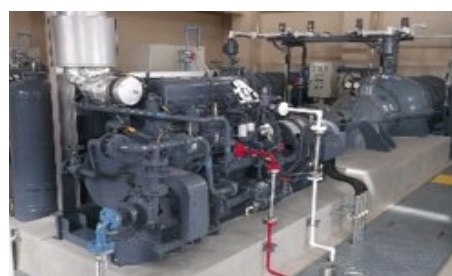
④復旧状況(H27.3)
