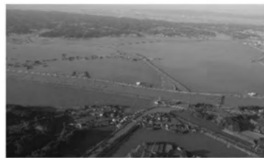
豪雨による甚大な湛水被害
