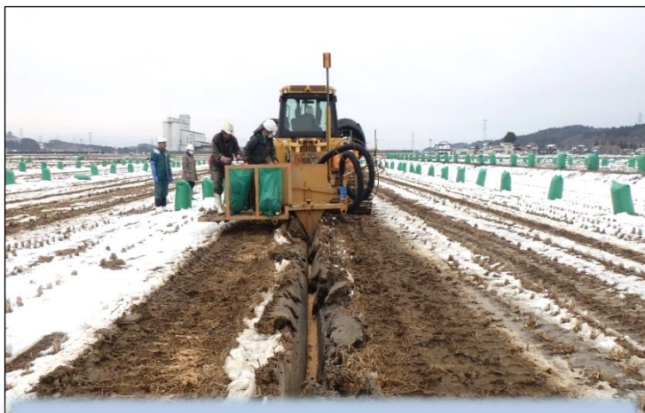
暗渠排水工事(FOEAS)施工状況（稲屋敷・袋地区）
