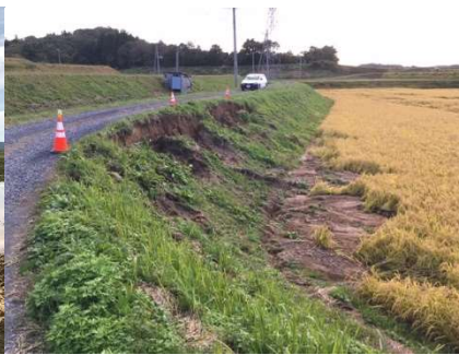
△農道の法面崩落
