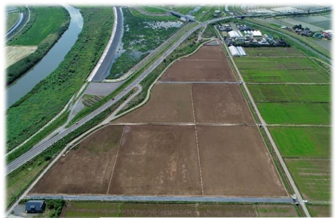
大目3-1工区 工事完了後の様子
