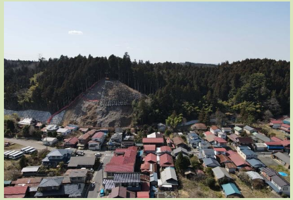
川口 急傾斜地崩壊対策事業
