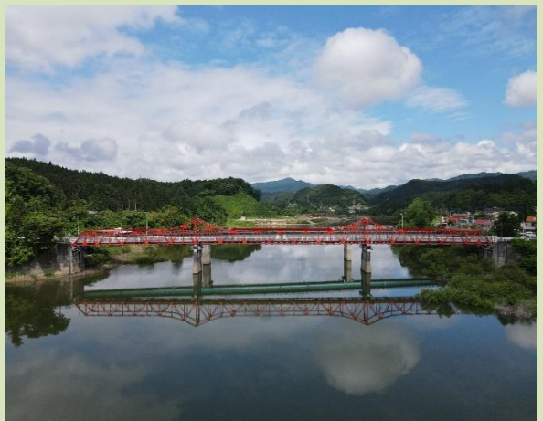
国道398号 座主歩道橋橋梁補修事業
