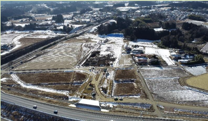
みやぎ県北高速幹線道路 (仮称)栗原インターチェンジ整備事業
