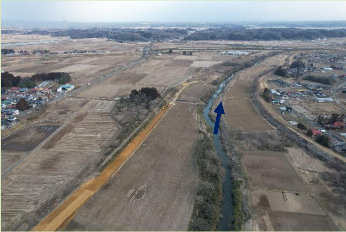
一級河川迫川(築館工区)河川改修事業
