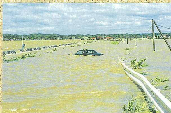
品井沼遊水地周囲堤を越水する氾濫水
